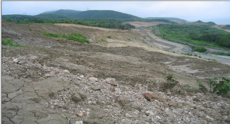
Оползень вязкопластического течения на западном побережье о. Сахалина (117-119 км железной дороги). Размещение отвала строительных грунтов на теле оползня вызвала активизацию оползневых процессов.
