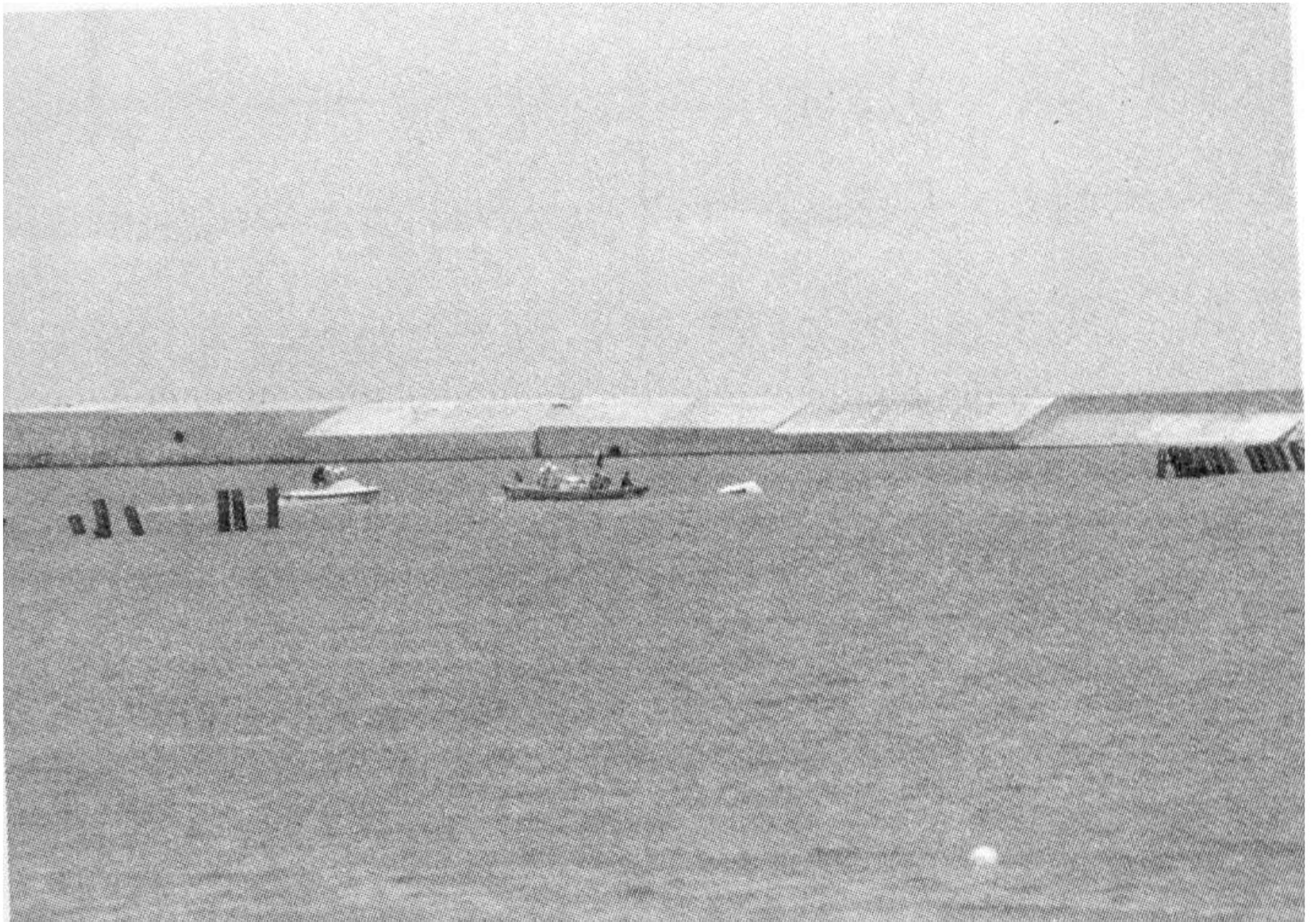
Опрокинутая защитная стена в порту Носиро в результате цунами 1983 г.
