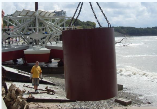
Промежуточные плавучести – железобетонные «бочки» - демпферы
