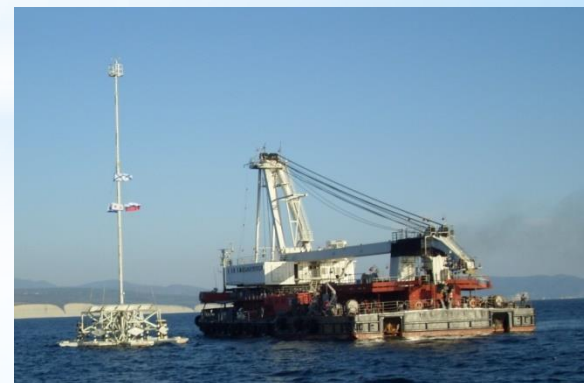
Конец постановки буй – генератора плавучим краном
